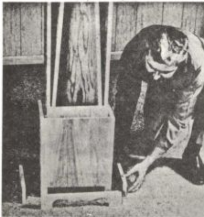
شکل ۲ - پایه‌ها و حاشیه‌های کناری را قبل از نصب حاشیه جلو به بدنه متصل سازید.
