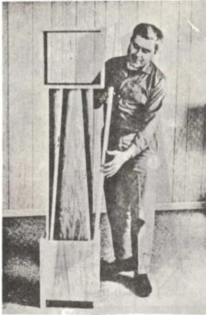
شکل ۱ - ابتدا قطعات قسمت پایه ساعت را جفت کرده و سپس با چسب و میخ قطعات کناری را به صفحه پشت متصل کنید. بریدگی پایینی ساعت برای خروج صدا از قسمت مورب تعبیه شده است.
